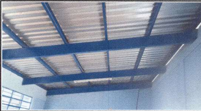
Foto1: sustitución de lámina
