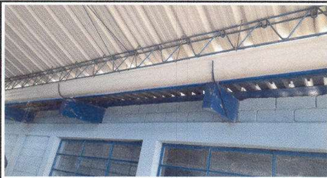
Foto 3: cambio de canales
