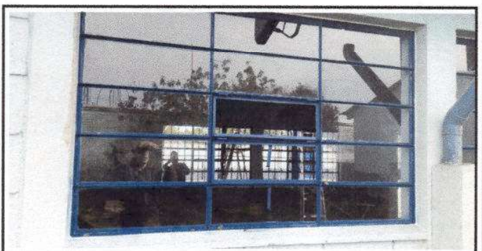
Foto 6: cambio de ventanas
