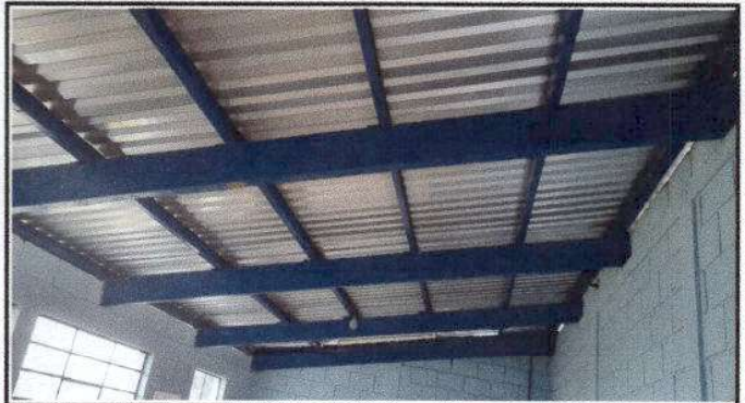
Foto 2: sustitución de lámina
