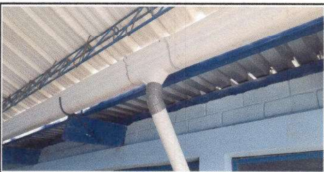
Foto 5: cambio de bajadas de agua
