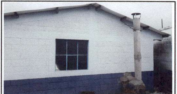
Foto 4: sustitución de chimenea
